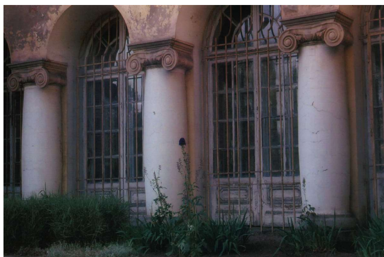
Zdjęcie nr 3. Fragment elewacji południowej
