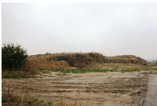
Fot 9. Zrekultywowane składowisko odpadów komunalnych w miejscowości Smolice
