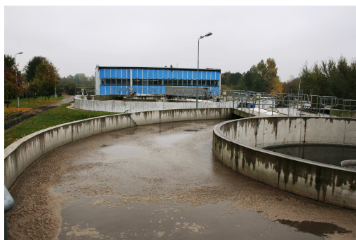
Fot 8. Oczyszczalnia ścieków w Strykowie
