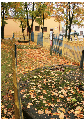
Fot 6. Ujęcie wody w Strykowie przy ul. Brzezińskiej
