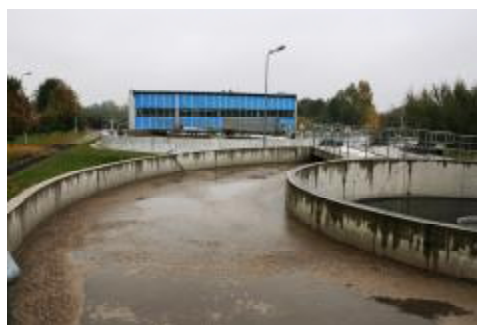
Fot 8. Oczyszczalnia ścieków w Strykowie
