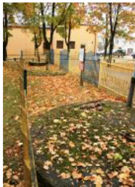
Fot 6. Ujęcie wody w Strykowie przy ul. Kościuszki
