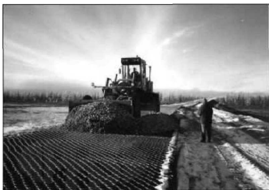
Rys. 9. Podbudowa nawierzchni drogowej wykonana przy uyciu geosiatki komórkowej a)
