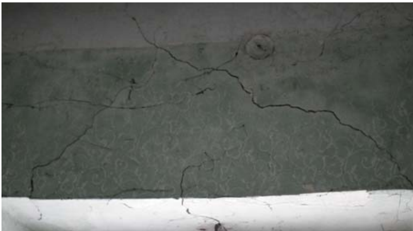
9. Spękania ściany od zewnątrz budynku
