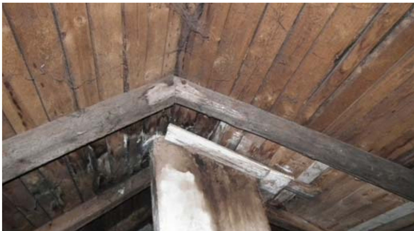
5. Zniszczone poszycie dachu przy kominie
