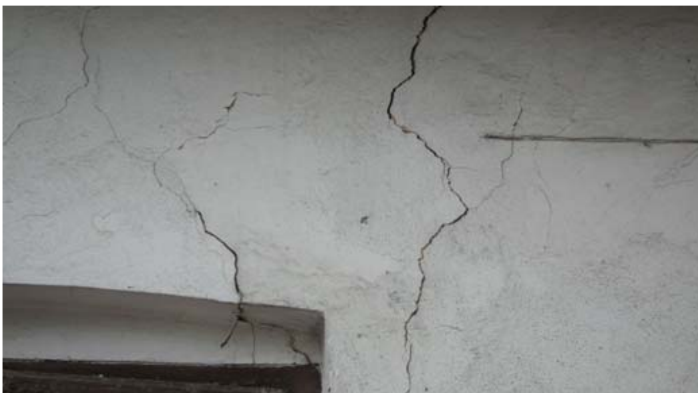
9. Spękania ściany od zewnątrz budynku
